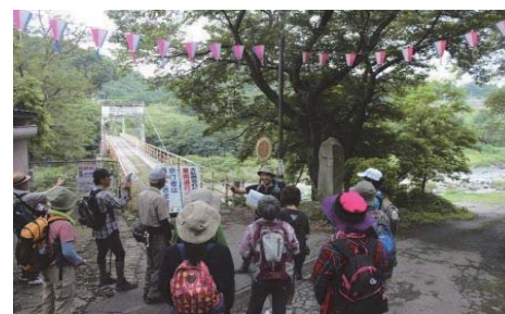
大杭橋 (小諸市で唯一の吊り橋)
